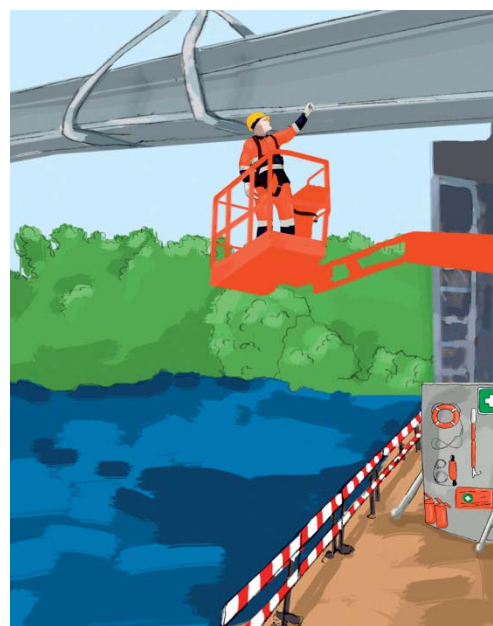
Rys. 4 Praca w podnośniku nad wodą
